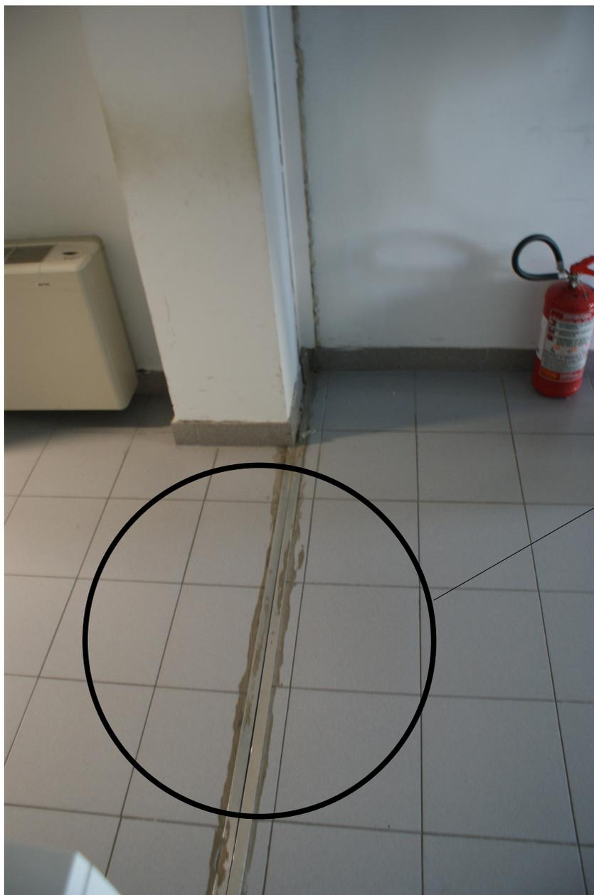
I segni dello scollamento del blocco di destra da quello centrale è visibile anche per terra (a sinistra, opportunamente coperto) e sul soffitto (a destra). Confortante (sic) la presenza dei simboli tipici della “sicurezza” intorno alla fessura.
